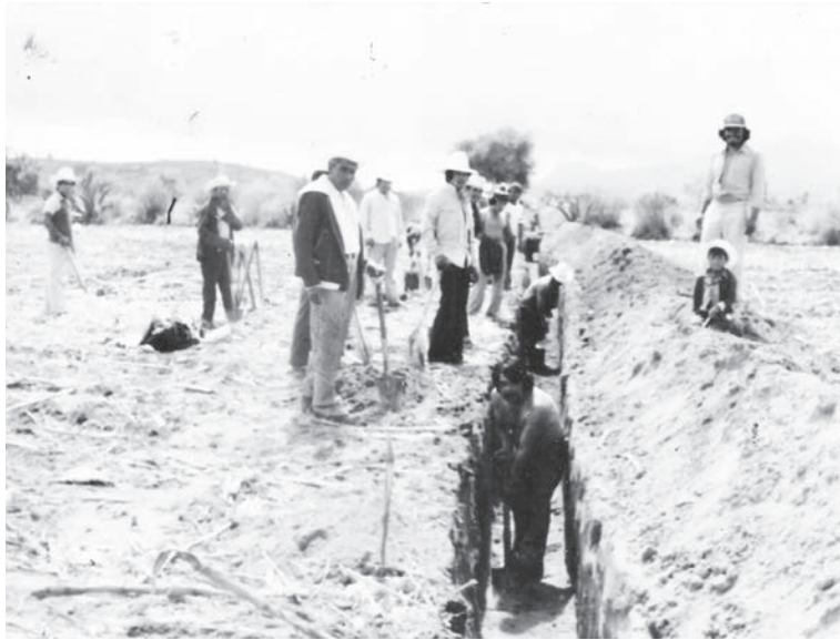
3. Faenas de locatarios de Zaragoza para la construcción de la red de agua potable. Fuente: Archivo personal de Gelasio González Altamirano.
